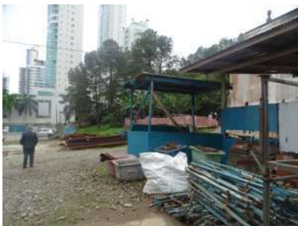
Foto nº 01 – Vista geral da área destinada à Rua Projetada “A” atualmente ocupada pela requerente.
